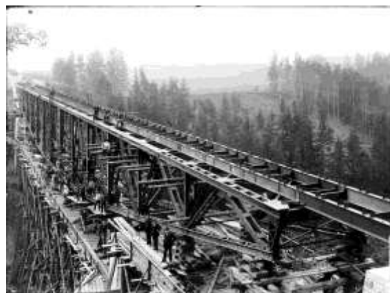
Montage des Eisenbahnviadukts über dem zukünftigen Stausee, 1908/09. Foto: MJG
